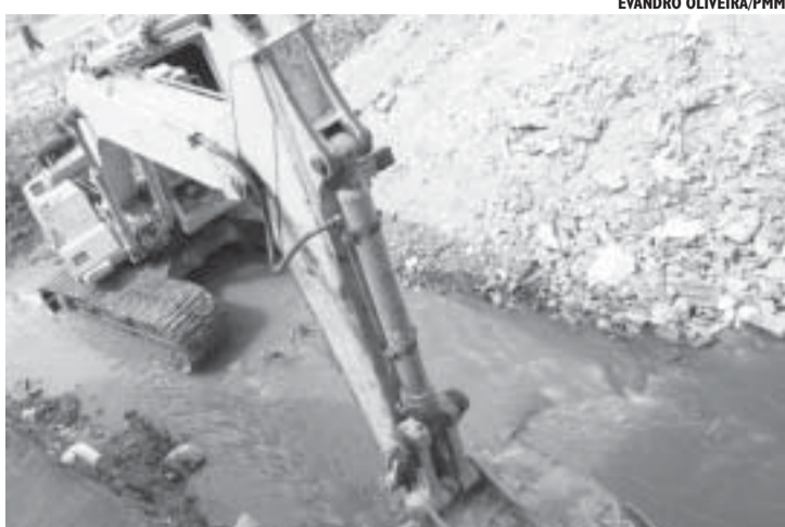
Máquina realiza a limpeza do córrego. Trabalho foi feito em um mês
